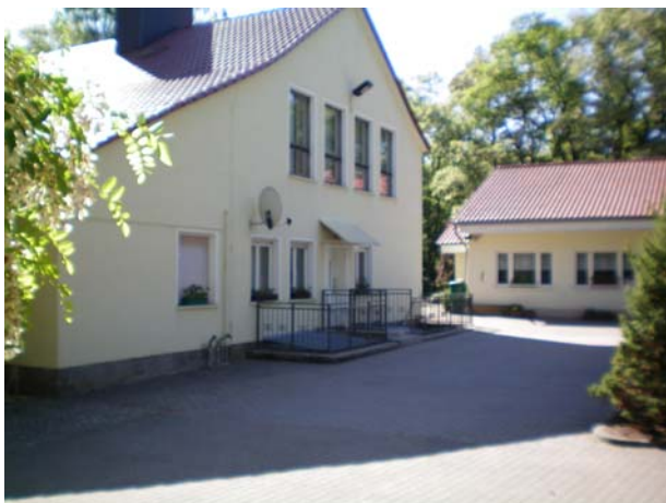
Ansicht Giebel Hauptgebäude
