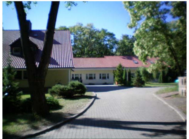
Ansicht Haupt- / Nebengebäude
