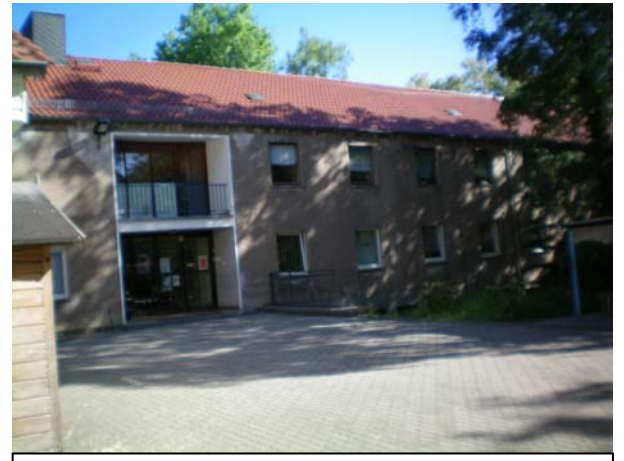
Ansicht Hofseite Hauptgebäude
